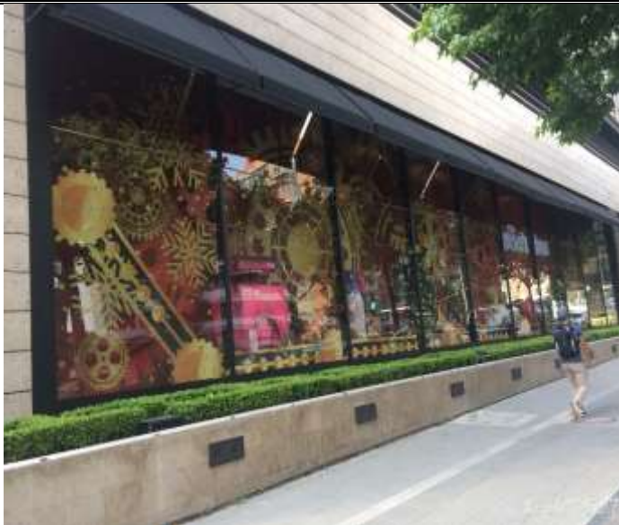
Fotografía No. 3. El predio cuenta con Publicidad Exterior Visual dentro de una edificación con una fachada en vidrio orientada hacia la vía pública (conducta 2 evidenciada). Fecha de la Visita: 16/01/2017.
